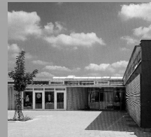
Bauleitung Altenhilfezentrum Steinheim 2000 (Ackermann + Raff Tübingen)
